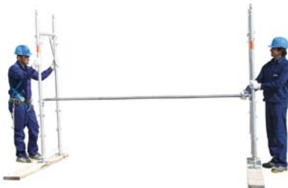
5 • montaje del segundo bastidor con parapeto
