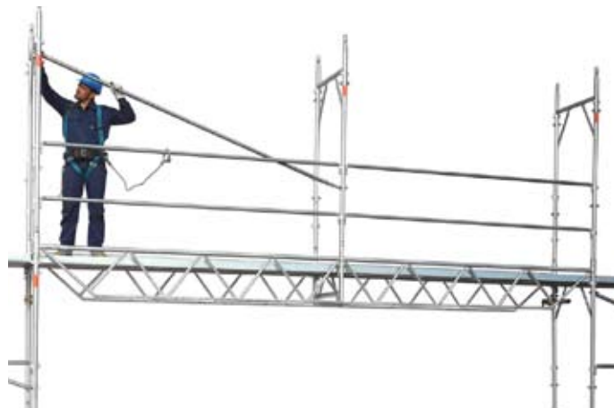
70 • montaje diagonales en vista encima de las vigas reforzadas
