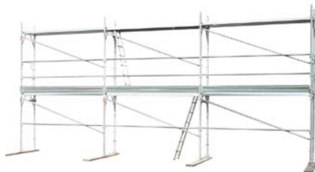
47 • montaje de plataformas en todos los módulos del nivel 2
