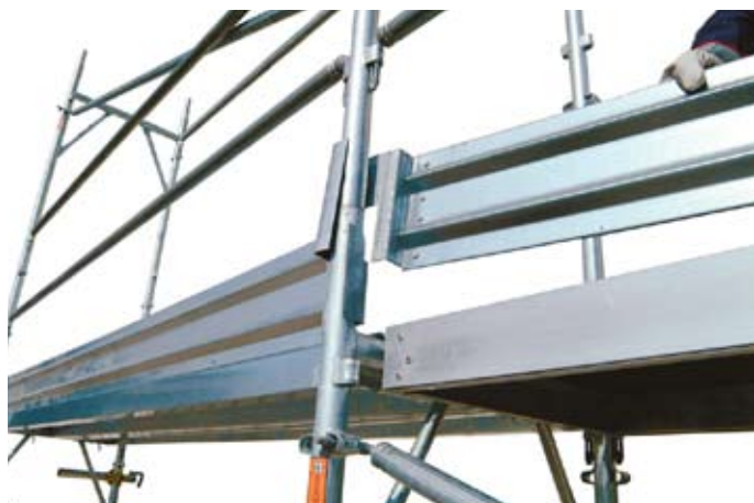
37 • detalle de rodapié en el nivel 1
