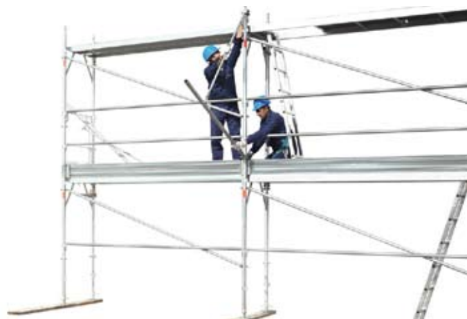
53 • montaje de las protecciones contra piedras
