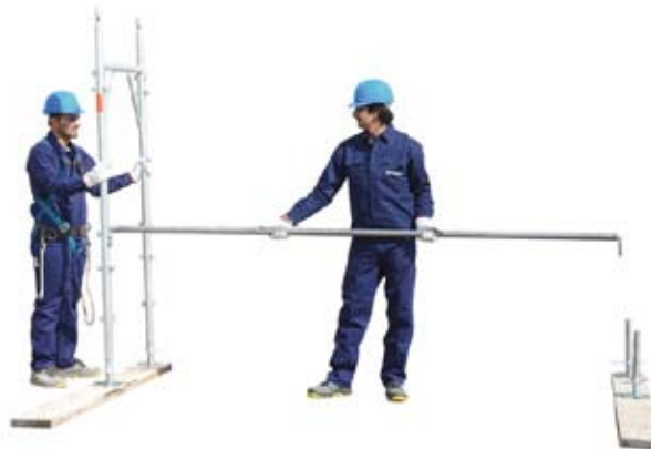
4 • introducción de elemento longitudinal
