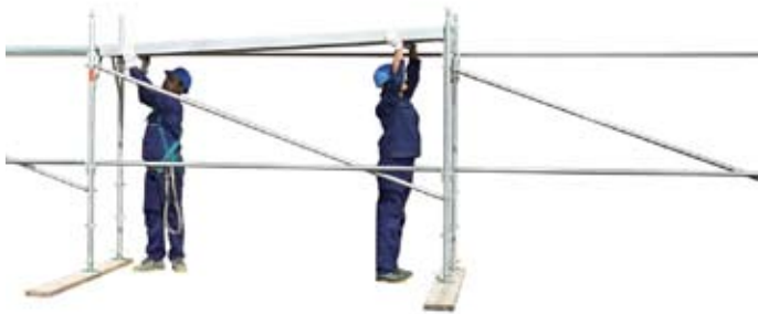
19 • montaje de plataforma con trampilla
