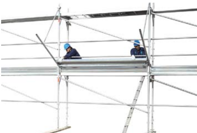
56 • montaje plataformas de la protección para piedras
