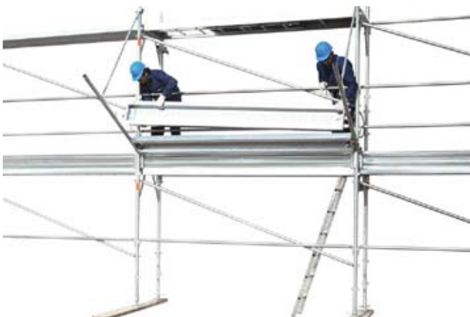
57 • montaje plataformas de la protección para piedras
