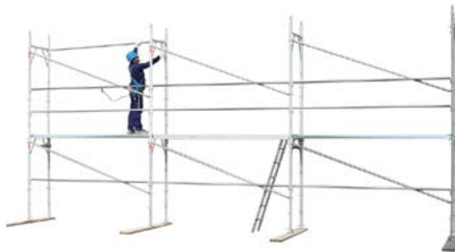
35 • montaje de elemento longitudinal posterior en el nivel 1
