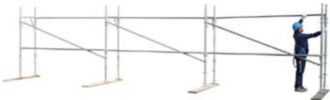
13 • montaje de módulos sucesivos
