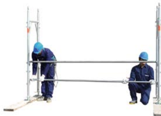
6 • montaje de segundo elemento longitudinal
