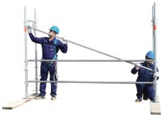
7 • montaje diagonal en vista
