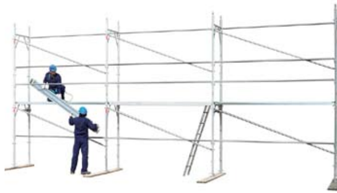
36 • montaje de placa rodapié en el nivel 1
