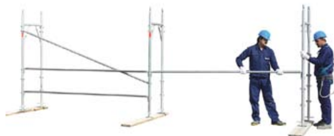
11 • montaje de módulos sucesivos
