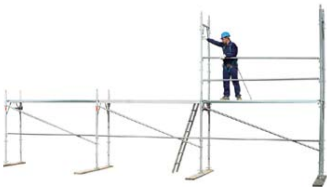
32 • montaje de parapeto en el nivel 1
