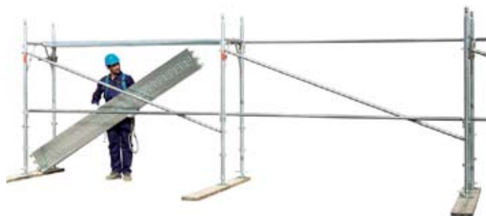
17 • montaje de las plataformas metálicas
