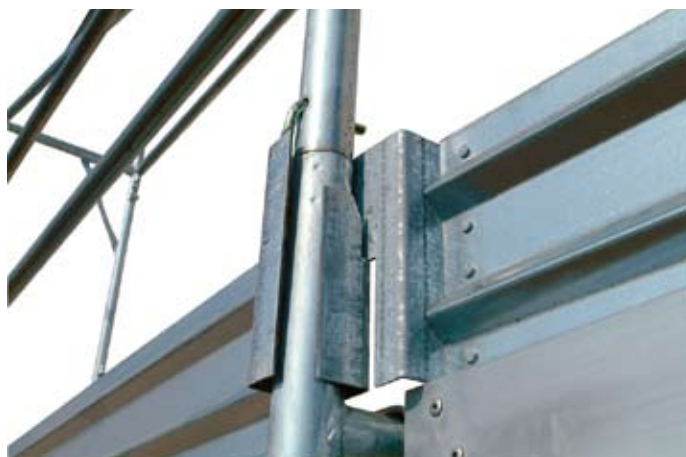
38 • detalle de rodapié en el nivel 1
