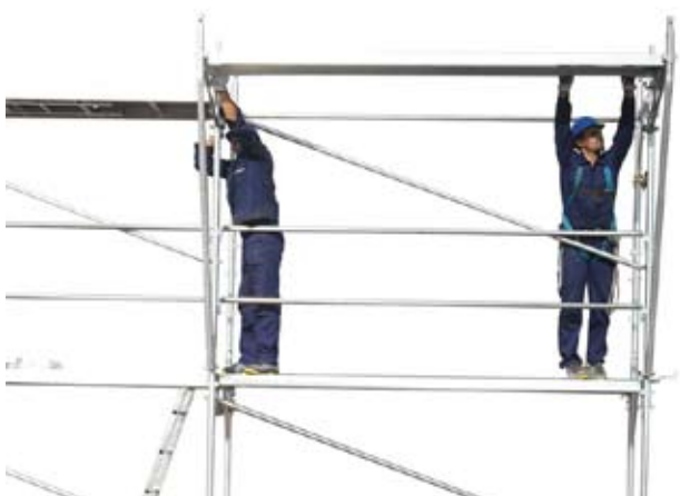
62 • montaje plataformas sobre la ménsula
