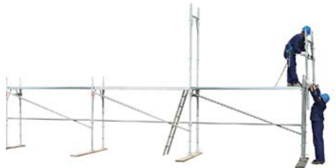
28 • inicio montaje bastidor en el nivel 1
