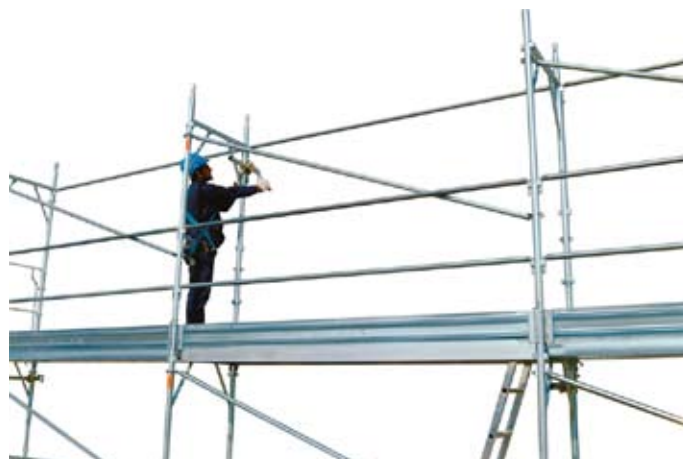
42 • montaje del anclaje en el nivel 1 donde se requiera
