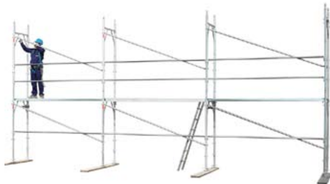
34 • montaje de módulos sucesivos en el nivel 1
