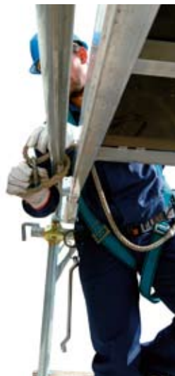
24 • atadura de la cuerda de retención antes de salir al piso
