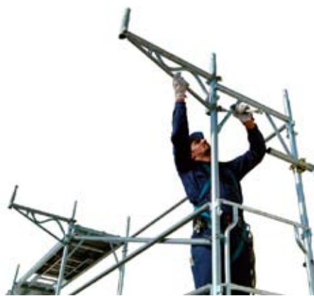
59 • montaje ménsula con puntal
