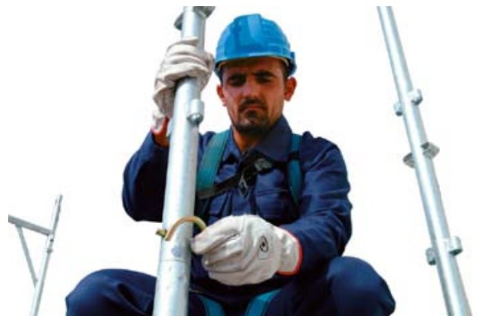
29 • montaje clavijas de los aviones
