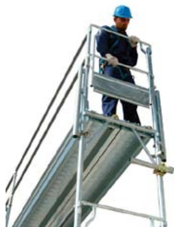
52 • montaje parapeto de cabeza en el nivel 2
