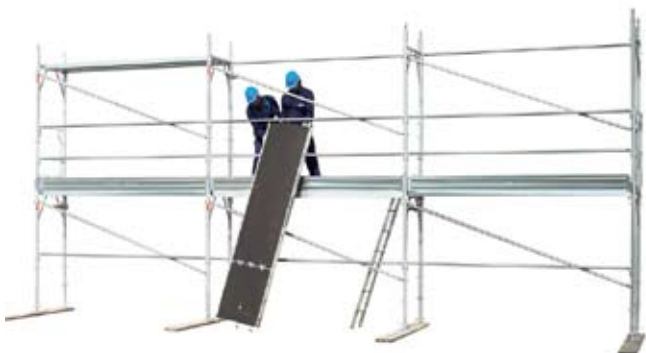
45 • montaje de plataformas con trampilla en el nivel 2
