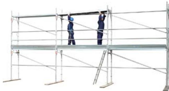
46 • montaje de plataformas con trampilla en el nivel 2
