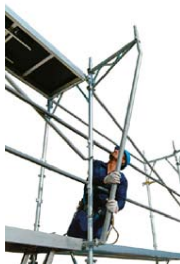
60 • montaje puntal de la ménsula
