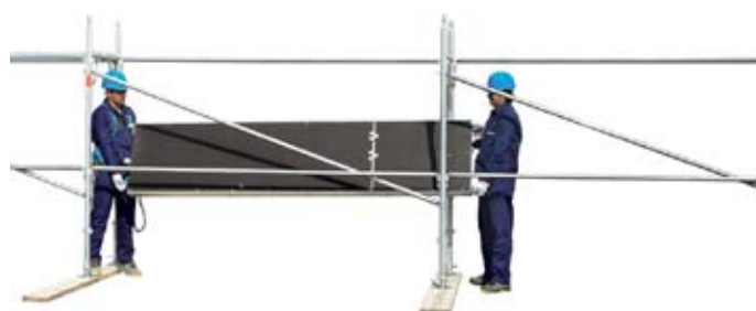
18 • montaje de plataforma con trampilla
