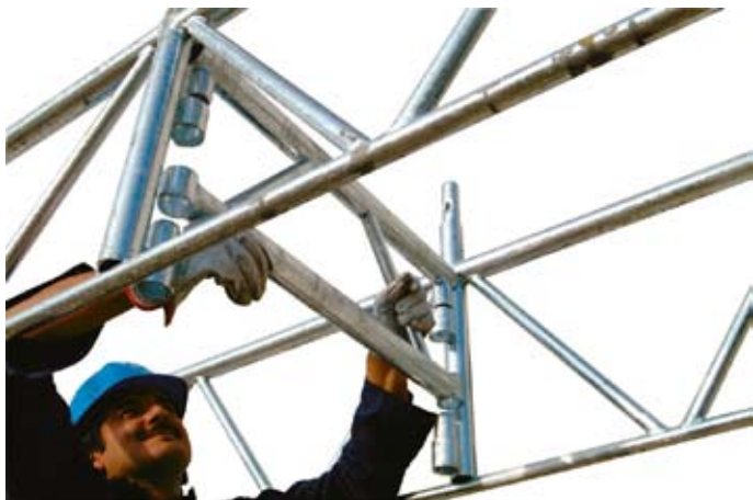
67 • montaje viga de unión de las vigas reforzadas
