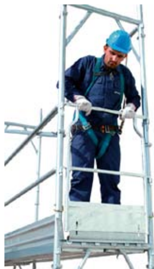
41 • Montaje parapeto de cabeza en el nivel 1
