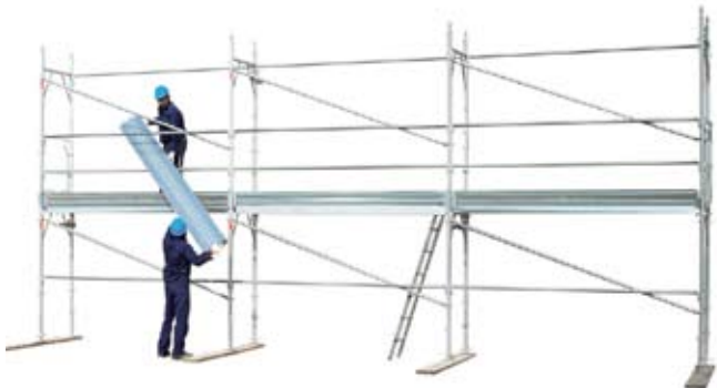
43 • montaje de plataformas en el nivel 2
