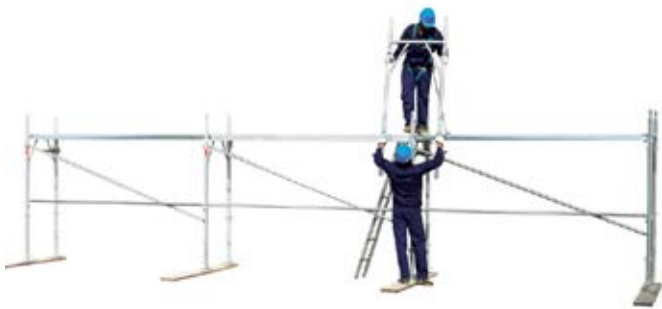
26 • inicio montaje de bastidores en el nivel 1
