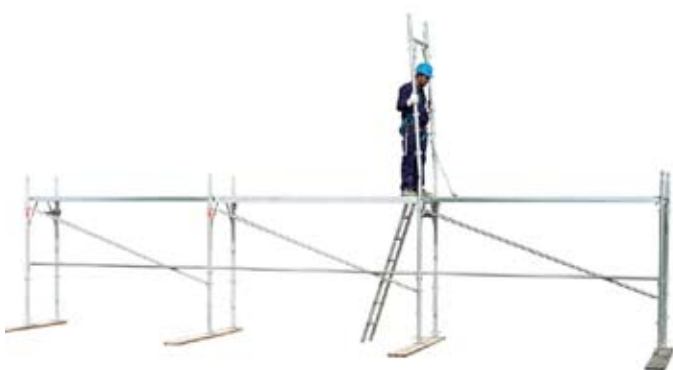
27 • inicio montaje bastidor en el nivel 1
