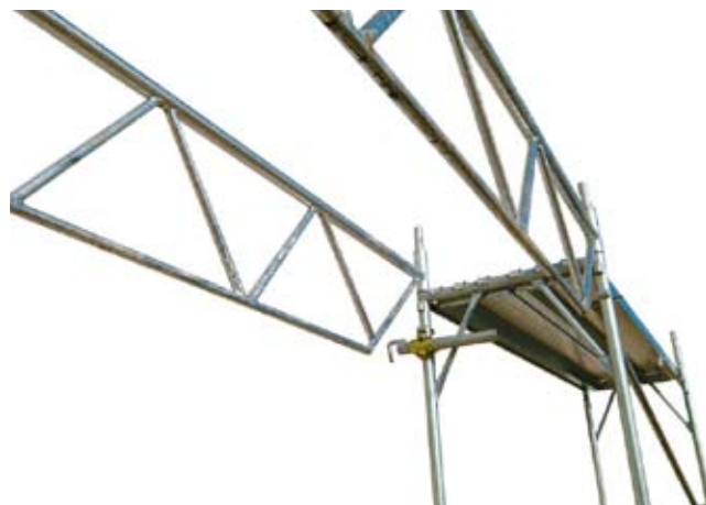
66 • montaje viga reforzada
