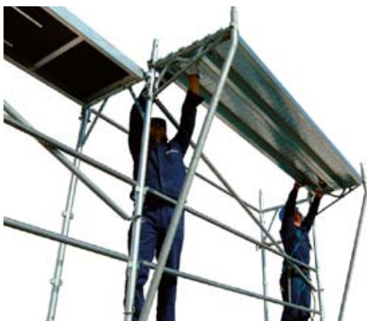
63 • montaje plataformas sobre la ménsula
