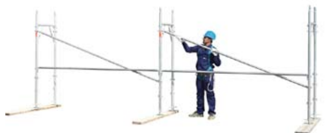
12 • montaje de módulos sucesivos
