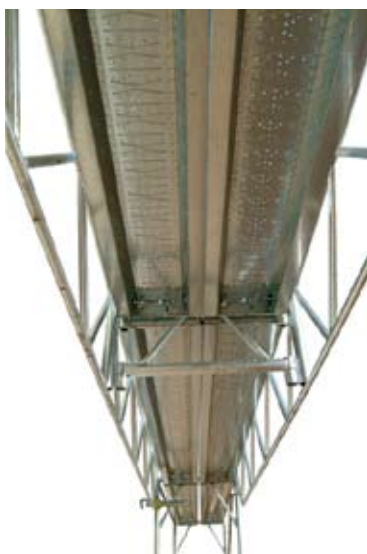
68 • montaje de entablado encima de las vigas reforzadas
