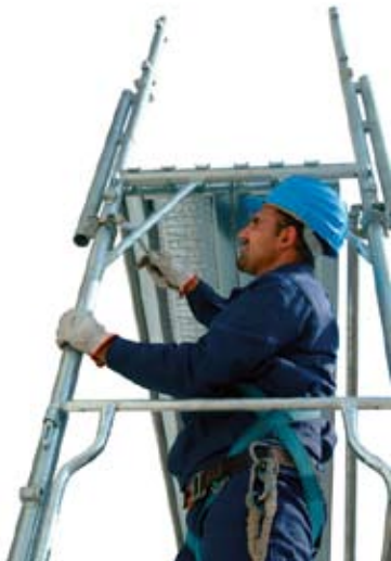
49 • apretamiento de junta del montante de vértice en el nivel 2
