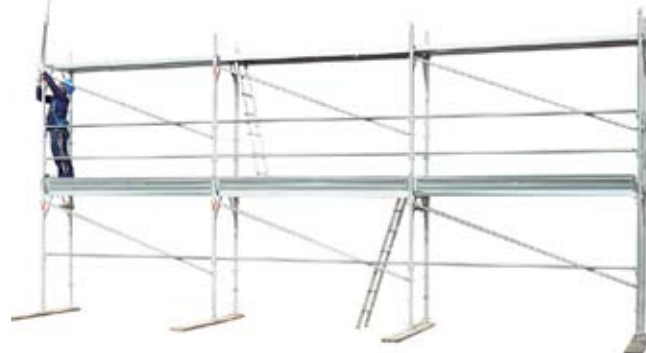
48 • montaje bastidor de vértice en el nivel 2
