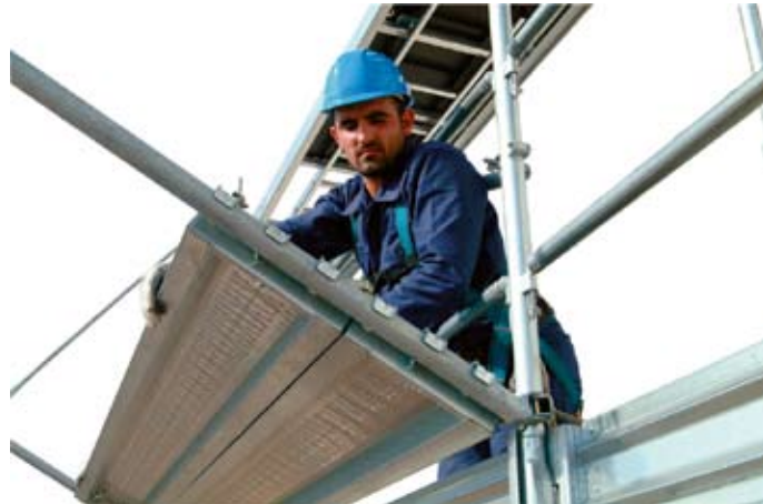
58 • detalle montaje plataformas de la protección para piedras
