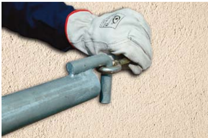
15 • introducción del anclaje
