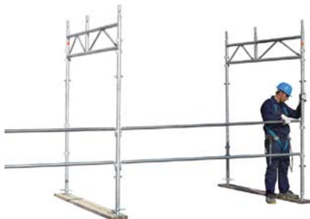
64 • montaje uniones del pórtico de paso peatonal
