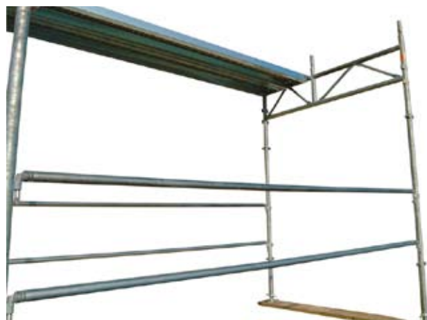
65 • montaje plataformas sobre el bastidor de paso peatonal
