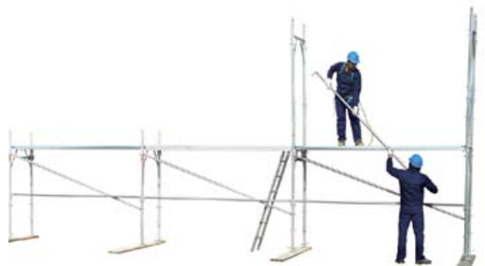
30 • montaje de elemento horizontal en el nivel 1
