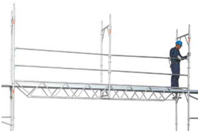
69 • montaje de los bastidores y elementos longitudinales encima de las cubiertas originales
