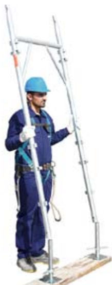
2 • colocación de bastidores
