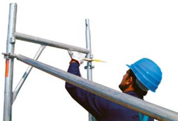
9 • comprobación de la distancia respecto a la fachada
