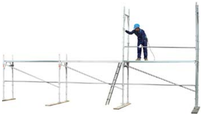
31 • montaje de elemento horizontal en el nivel 1
