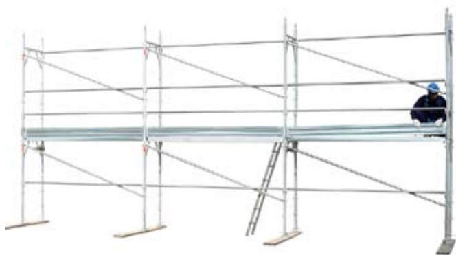
39 • montaje de rodapié en el nivel 1
