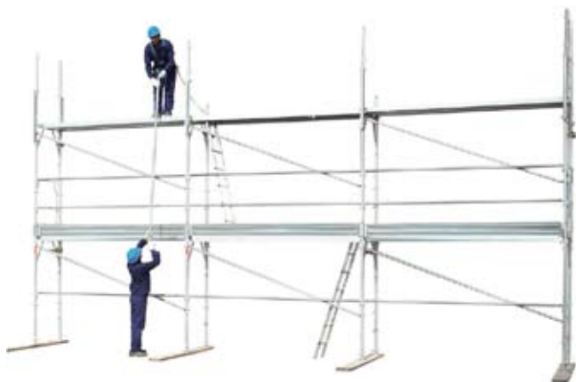
51 • montaje de elementos longitudinales y parapetos en el nivel 2
