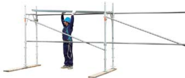
16 • montaje de las plataformas metálicas
