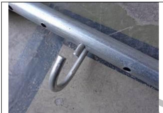
**Fotografía 2.5:** Detalle del pasador utilizado como fijador de altura en la alzaprima.
