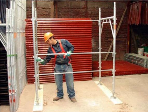
La conexión entre marcos debe realizarse mediante la fijación de los tensores horizontales al anclaje que tiene el marco
