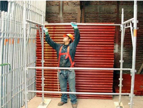
En el costado opuesto a los tensores ya instalados se debe colocar otro tensor en la parte superior (si el andamio está adosado al muro) o central (para ser usado como baranda), dependiendo del trabajo a realizar
