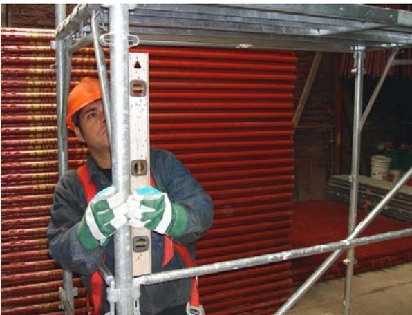
Si en los módulos superiores existe dificultad para encajar los tensores, se debe volver a nivelar el módulo base.
