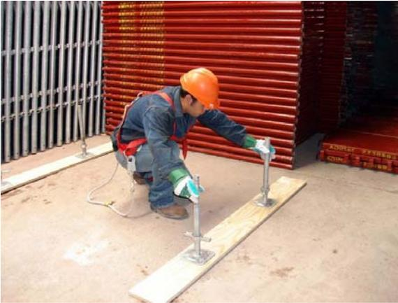
Las bases regulables deben estar ubicadas siguiendo la medida de las bandejas y sobre un piso resistente, si es necesario, para uniformar la presión del **andamio** sobre el piso, se puede utilizar tabloncillos de reparto de 2" o más.
