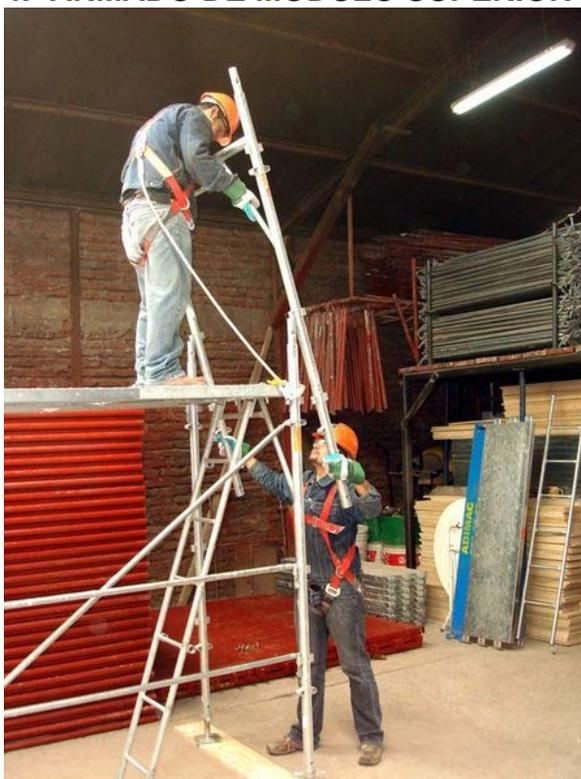
Se deberá insertar los marcos en los extremos superiores del módulo base.
