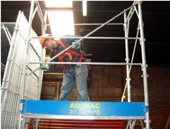
Al igual que en el caso anterior, los tensores diagonales se instalan de la misma forma que en el módulo base.
